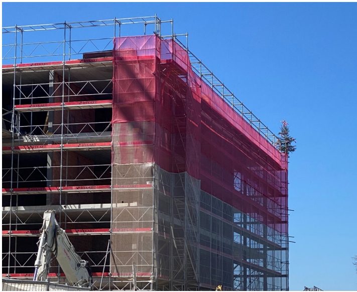
Juni 2021: Der Neubau hat den Dachfirst erreicht (bzw. das Flachdach), was mit einer Aufrichte-Feier zusammen mit den Handwerkern gefeiert wurde.
