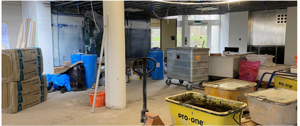
Foyer und Cheminéeeraum dienen zurzeit noch als «Bauinstallationsfläche».
