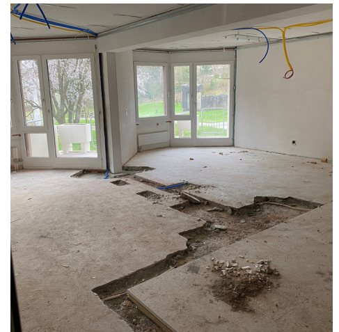
Links der Festsaal, rechts der Aktivierungsraum im 1. OG, bei dem man die Spuren von Abbruch Trennwand und Nasszellen noch deutlich sieht.
