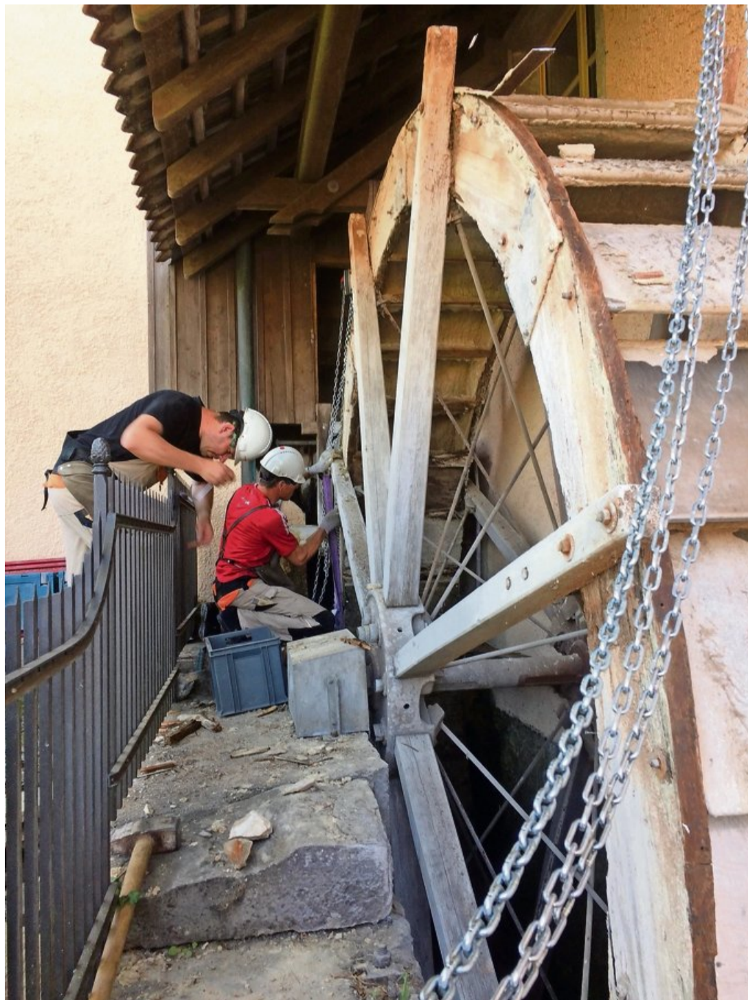
Mitarbeiter der Wagnerei Oehrli zerlegen das Mühlrad der Lindenmühle aus dem Jahr 1981.
