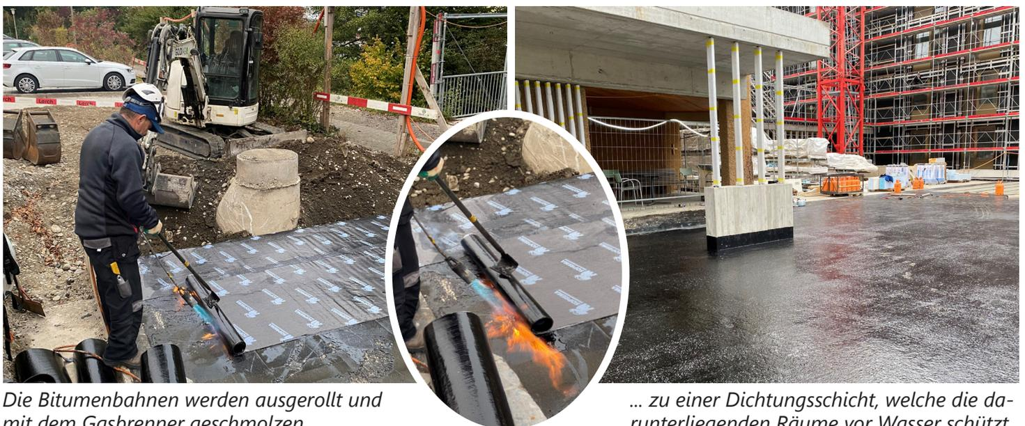
Die Bitumenbahnen werden ausgerollt und mit dem Gasbrenner geschmolzen...
